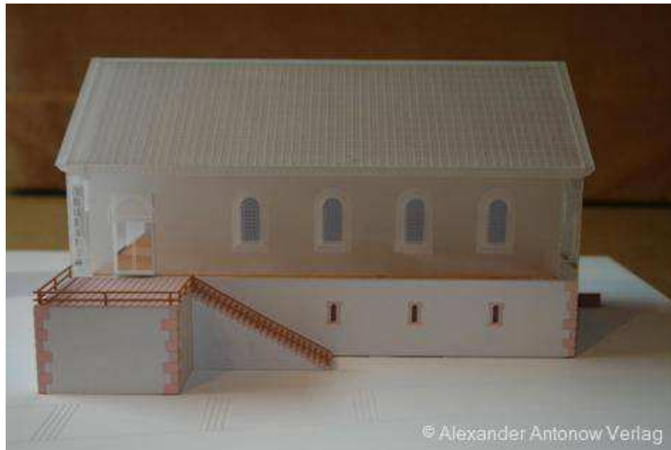
Abb. 5 Modell der Königshalle, Ansicht von Süden mit dem Treppentempel Der große Saal im Obergeschoss besaß breite, nach innen ausladende große Fenster mit kleinen Glasscheiben. Die Lichtöffnungen im Erdgeschoss mit einer Breite von etwa 25 - 40 cm hatten keine repräsentative Aufgaben. Sie sollten -wie im frühen Mittelalter bei fast allen Profanbauten üblich- besonders in den kalten Jahreszeiten nur begrenzt Licht und Luft in den Raum lassen. Aus historischer Sicht wären die hier dargestellten Fensteröffnungen denkbar.
