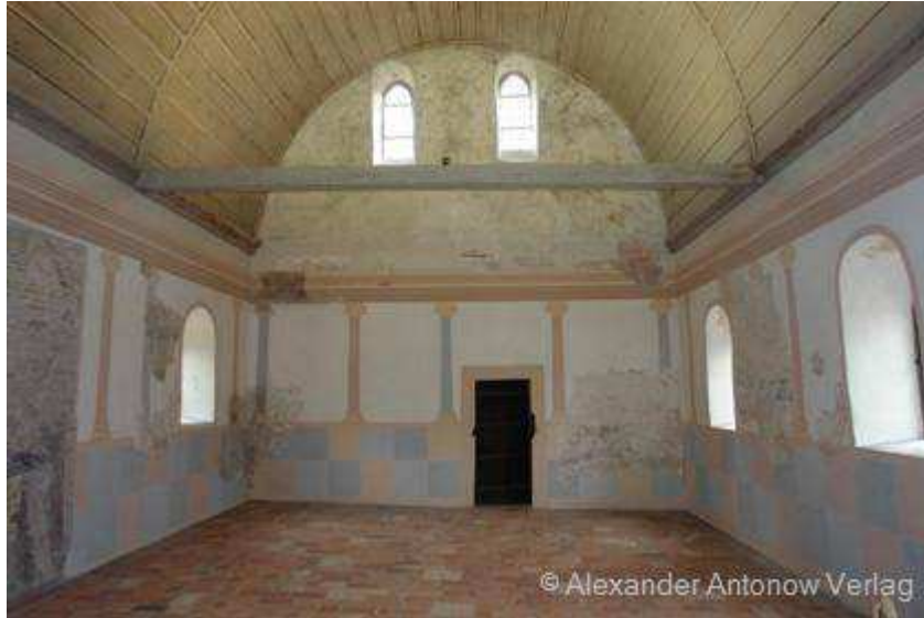
Abb. 13 Südseite des Obergeschosses des Torgebäudes des Klosters Lorsch/Lkrs. Bergstraße mit wiederhergestellter Wandbemalung und originalen Fenstern und Türen Einziges original erhaltener Raum eines Profangebäudes aus der Karolingerzeit in Deutschland. Das weitaus größere Obergeschoss der Frankfurter Königshalle (innen 27,12 x 12,53 m groß) und auch die Königshalle der Pfalz Ingelheim (Abb. 7) dürfte eine ähnliche Ausgestaltung gehabt haben. Um 1400 wurde der Raum aufgestockt und erhielt eine hölzerne Spitztonne und Spitzbogenfenster.
