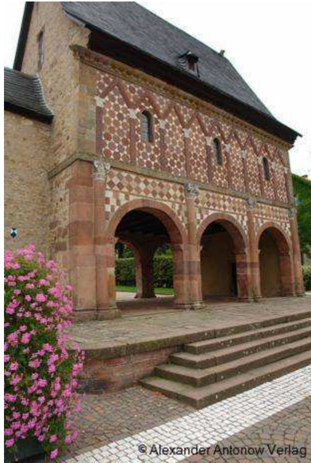
Abb. 11 Torgebäude (Feldseite) des ehem. Klosters Lorsch/Lkrs. Bergstraße; vermutlich nach 876 im Rahmen des Ausbaues des Klosters zur ostfränkischen Grab- lege (Ludwig II., der Deutsche) errichtet.
