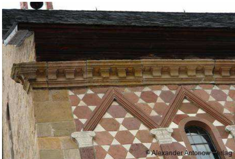
Abb. 12 Südostecke (Feldseite) des karolingischen Torgebäude des Klosters Lorsch/Lkrs. Bergstraße mit Dachgesims und Zahnleiste mit einer Reihe kleiner Konsolen. Diese Dachkonstruktion wird es sicher bei der Frankfurter Königshalle auch gegeben haben.
