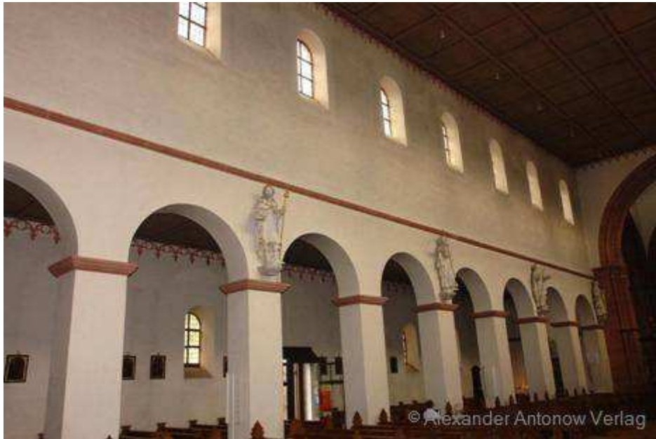
Abb. 15 Mittelschiff (9,35 m breit) der Klosterkirche in Seligenstadt/Lkrs. Offenbach, um 834, mit originaler karolingischer Nordwand über -aus Ziegeln gemauerten Pfeilern. Der obere Teil der Seitenwände dürfte auch gut den Eindruck der etwa halb so hohen and des Obergeschosses der Frankfurter Königshalle wieder gegeben haben. Im Hintergrund rechts der hohe Spitzbogen der Vierung aus der Mitte des 13. Jhs.
