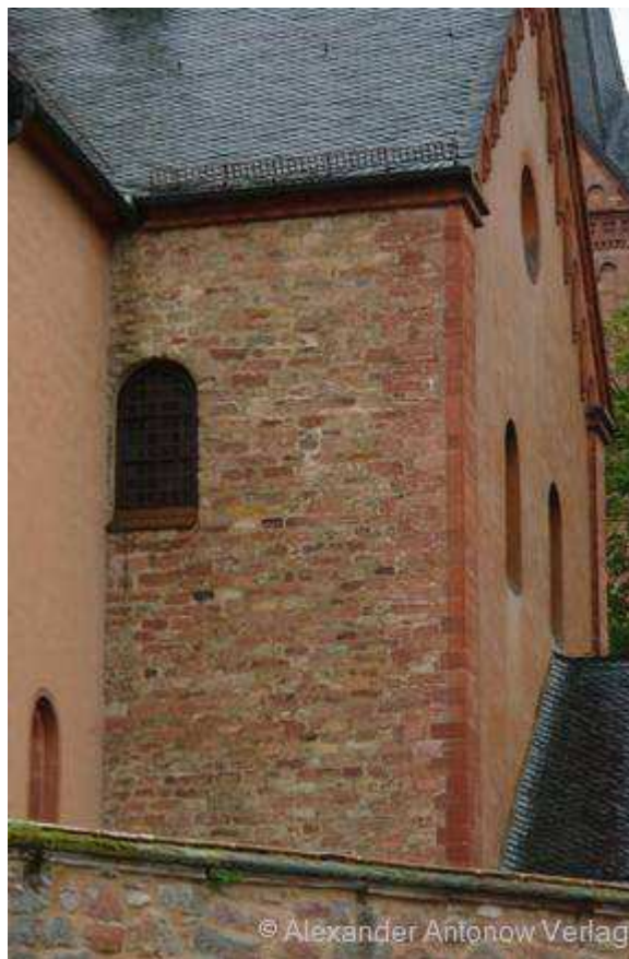
Abb. 14 Originales großes rundbogiges Fenster in der Ostwand des nördlichen Querschiffes der karolingischen Klosterkirche von Seligenstadt/Lkrs. Offenbach, um 834; ähnliche Fenster dürfte es im Obergeschoss der Frankfurter Königshalle gegeben haben.
